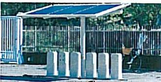
La pensilina solare prototipale per la ricarica di bici elettriche
